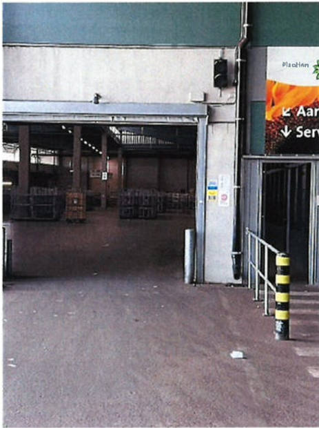
Bouwdeel C: Loopdeur naast roldeur
